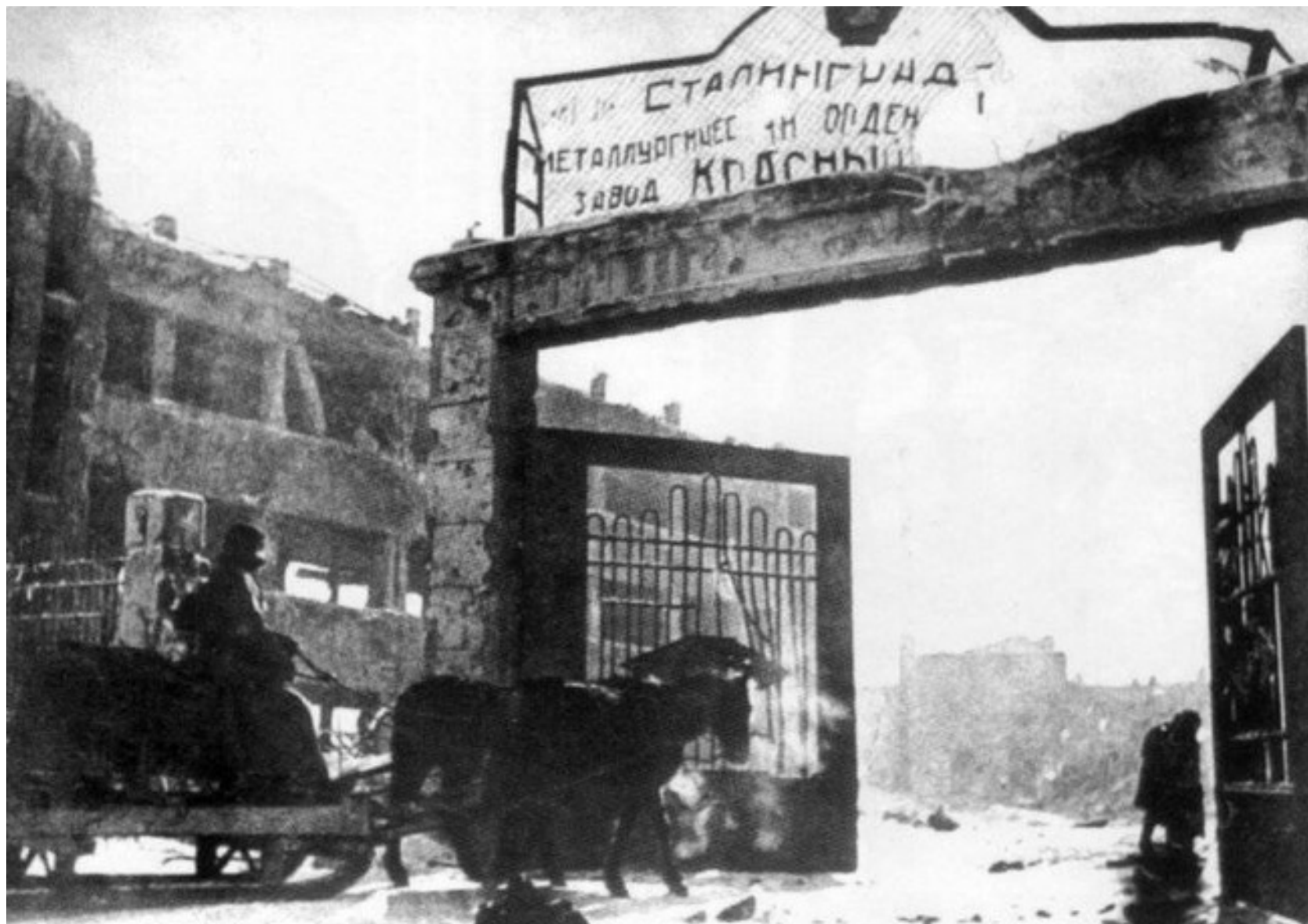
Центральный вход металлургического завода «Красный октябрь» после боя
